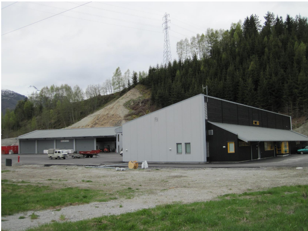
Verkstad, lager og miljøstasjon for FDV og brannstasjon for Valldal teken i bruk haust 2009.
